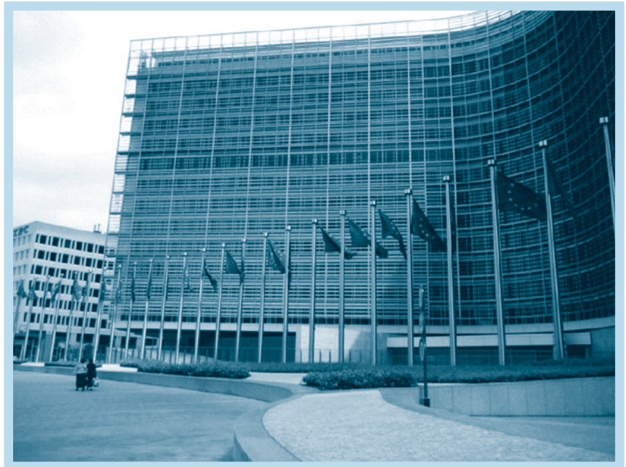
Europa gaf zelf het goede voorbeeld en realiseerde een drastische energiewinst met de renovatie van het Berlaymontgebouw.
